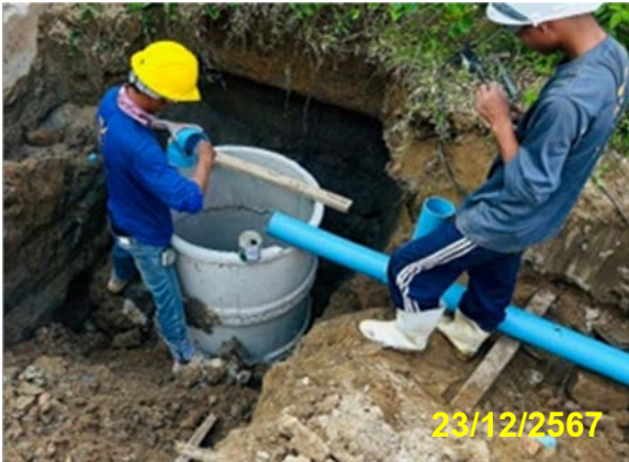
รูปที่ 2-29 ระบบบำบัดน้ำเสีย
