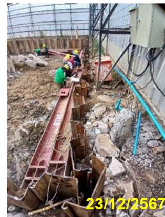
รูปที่ 2-14 เจ้าหน้าที่ตรวจสอบความมั่นคงของแนวกำแพง ป้องกันดินพัง
