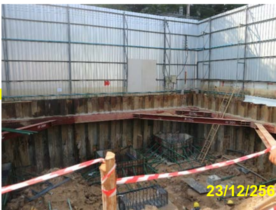
รูปที่ 2-12 ผนังกันดินชนิดเข็มพืดเหล็ก (Sheet Pile)
