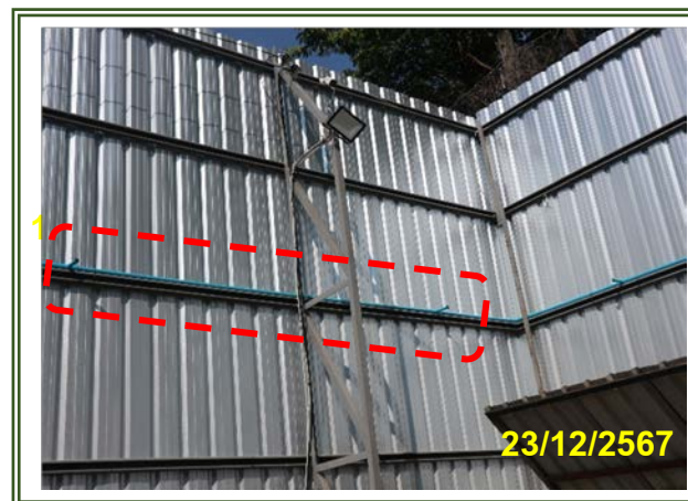
รูปที่ 2-22 หัวกระจายน้ำฝอยโดยรอบพื้นที่ก่อสร้าง
